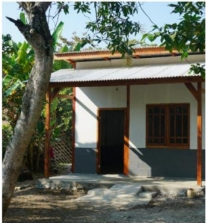
Kondisi rumah Maghfiroh setelah direhab Satgas
